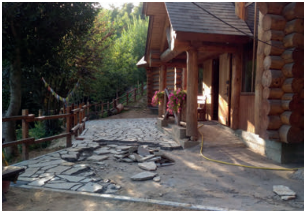
Pavimentazione (foto Beppe Traficante)
